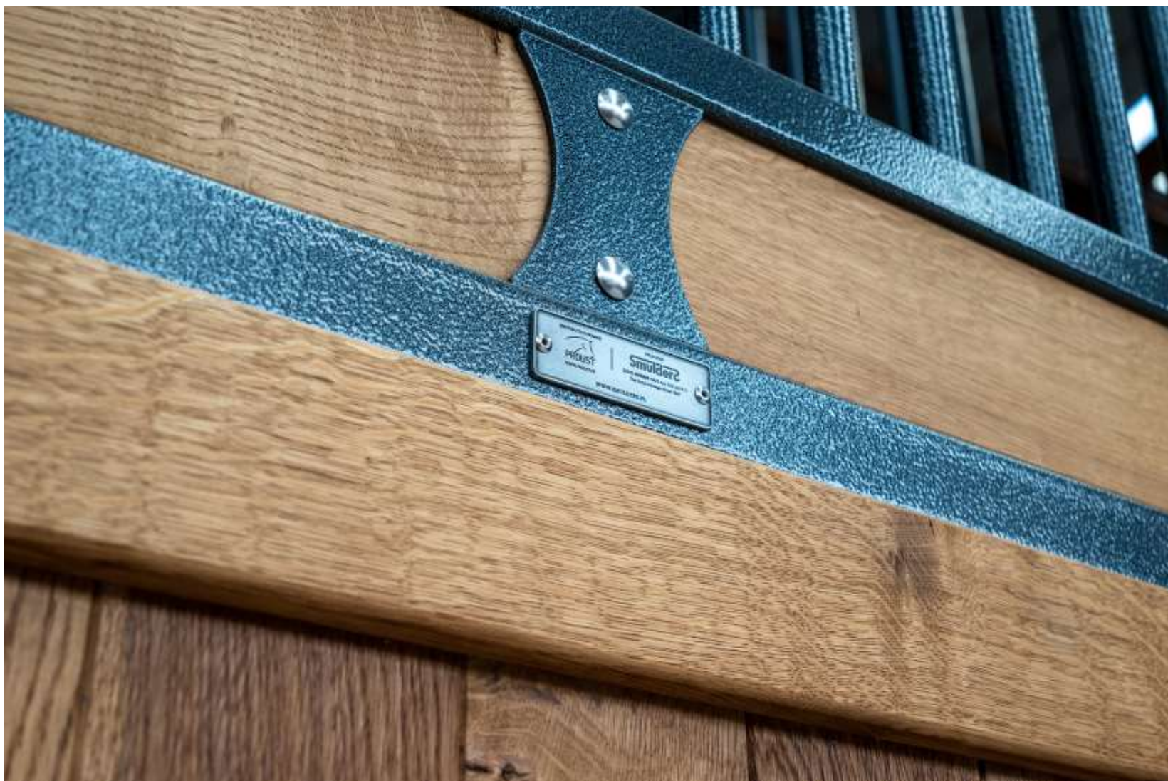
Détail d'un bandeau horizontal avec les finitions peinture gris martelé et planches en chêne lasuré.
